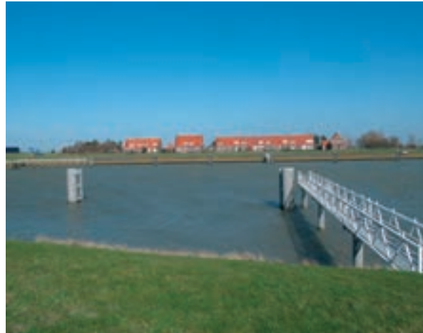
Kornwerderzand: beschutte voorhaven
