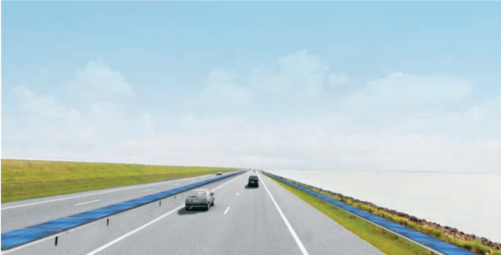
Onderzoek plaatsing zonnepanelen op de vangrails
