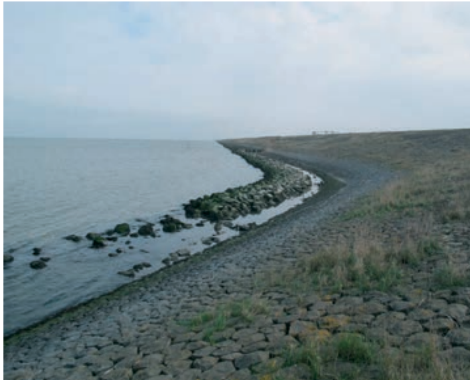
Bekleed buitentalud, flauwe helling
