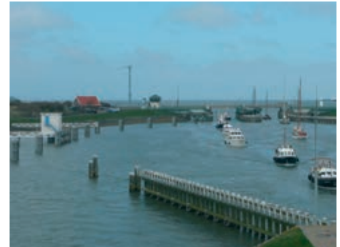
Doorvaart door voorhaven Kornwerderzand
