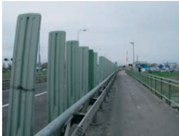
Fietspad op draaibrug
