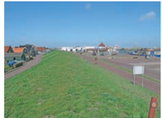
Den Oever: dijk tussen dorp en haven
