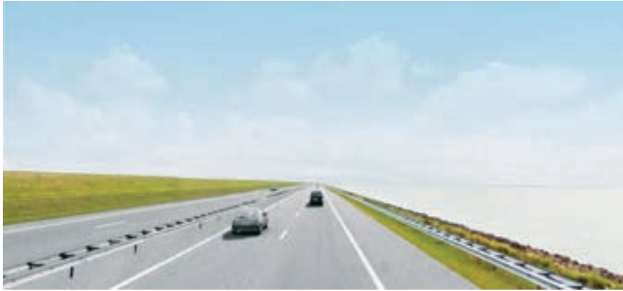
Aangepast talud na versterking dijk
