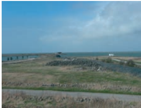
Fietspad op kruin van de dijk bij Kornwerderzand
