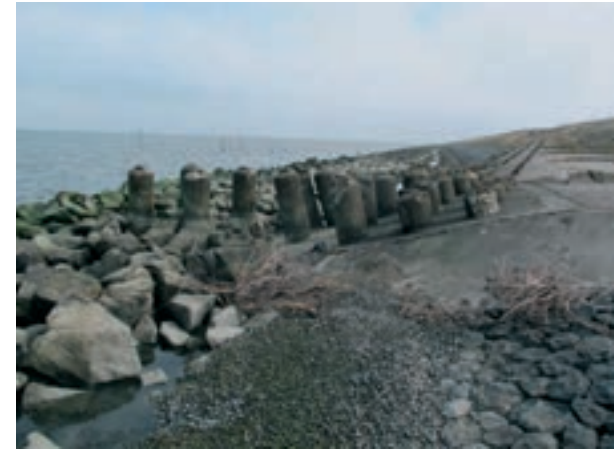
Tankversperring op de dijk
