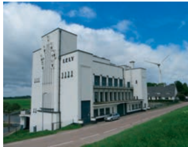
Gemaal Lely in de Wieringermeerpolder bij Medemblik
