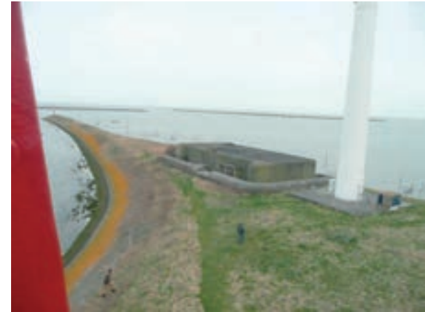
Kazemat op strekdam buitenhaven
