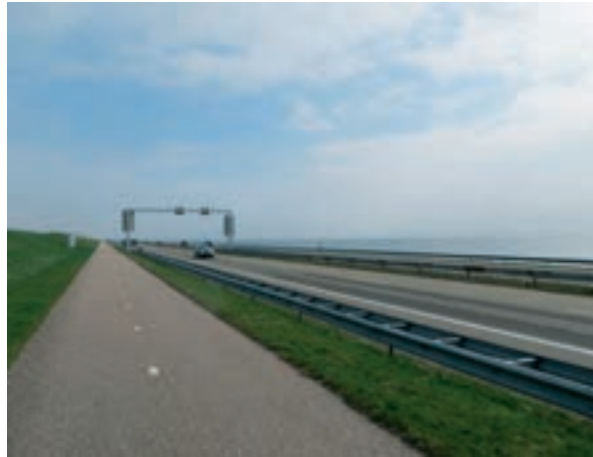
Fietspad tussen dijktaalud en autoweg
