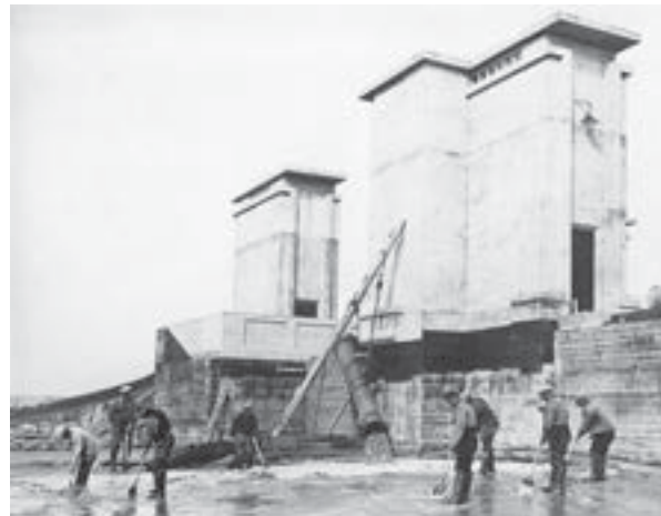
Aanleg van de sluiscomplexen
