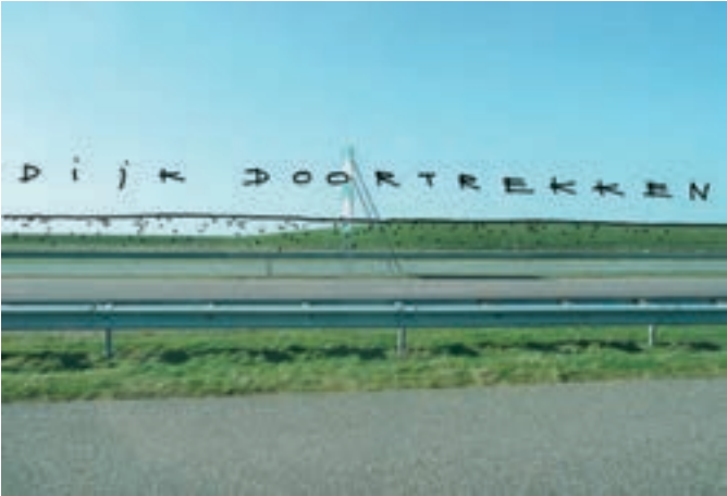
Dijkverhoging landhoofd tussen Friesland en Kornwerderzand
