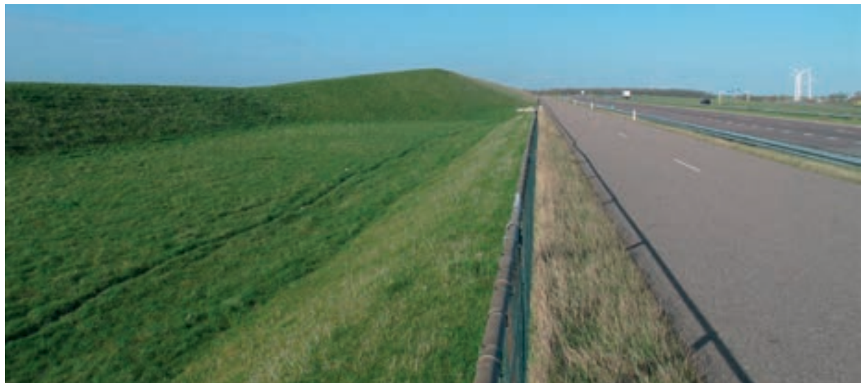
Waterkering tussen Kornwerderzand en Friese Kust: overgang van kruin op +7.50 m NAP naar kruin op + 9.50 m NAP
