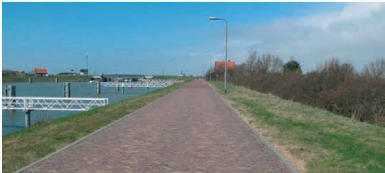
Waterkering rond voorhaven op + 5 meter NAP
