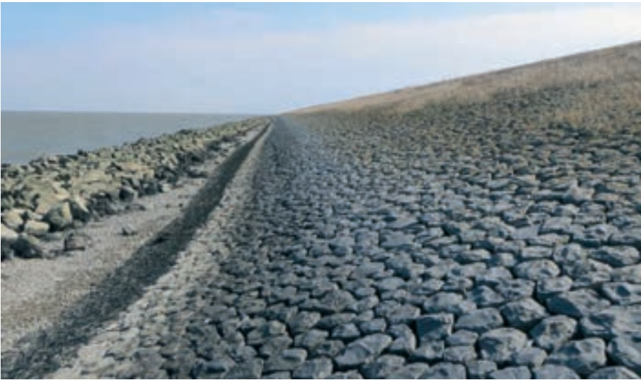
Basaltbekleding Afsluitdijk: fijnkorrelige textuur, verlopende kleuring van teen tot kruin
