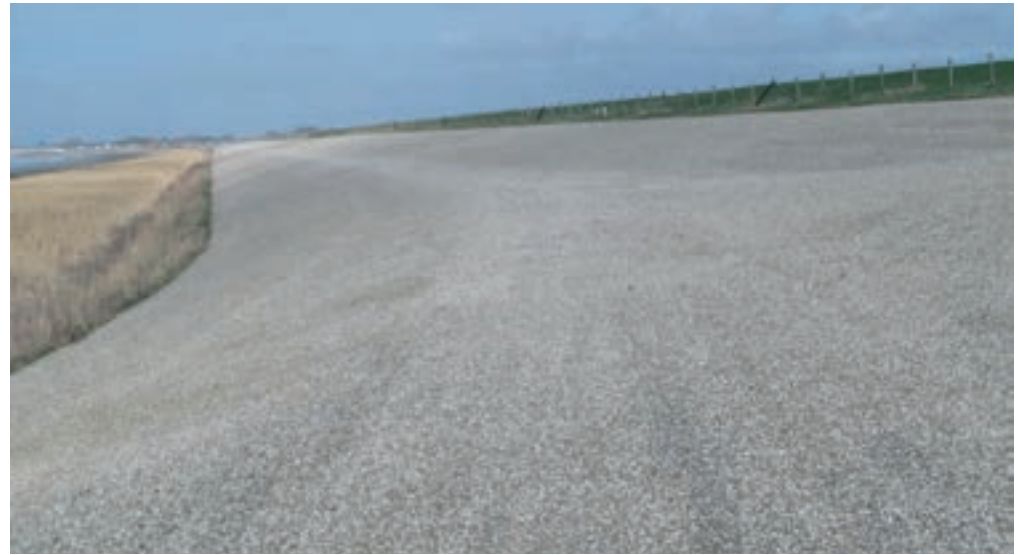
Met asfalt versterkte dijk Amsteldiep
