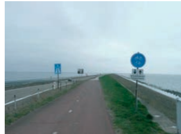
Fietspad op kruin van de dijk bij Breezanddijk
