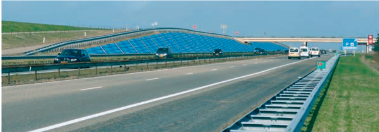
Als huid: bekleden binnentalud tussen de opritten (500 meter)
