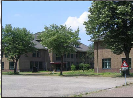
Ensemble Kolonel Palmkazerne 6 karakteristieke kazernegebouwen met een kopgebouw ter afronding van het exercitieterrein, opgetrokken in jaren 30 architectuur
