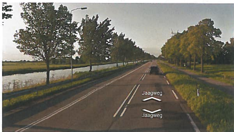
Huidige situatie Ipendam-Purmerend, een aanliggende busbaan
