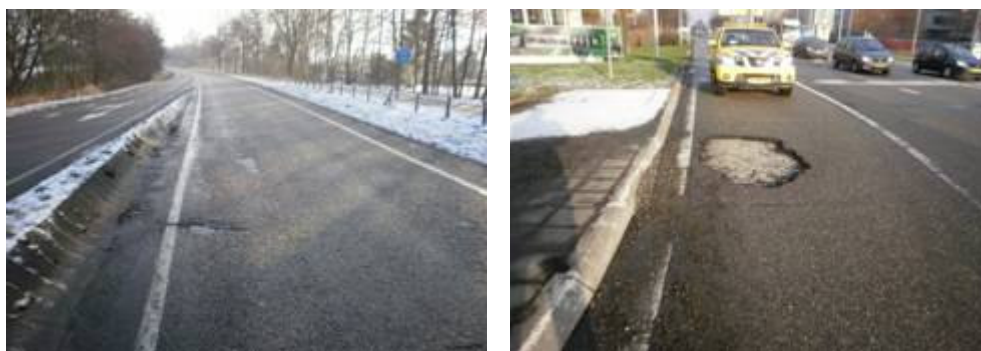
Figuur 8: Vorstschade op een provinciale weg.
