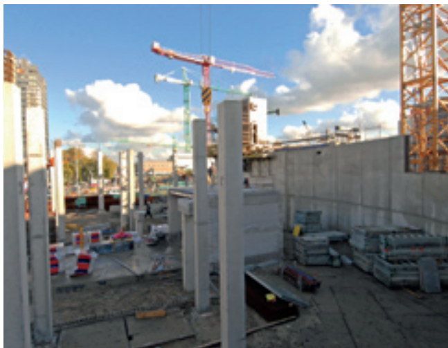
Het nieuwe Zaanse archief in het project Inverdan in aanbouw, 2008 (foto: Mieke Schaap)
