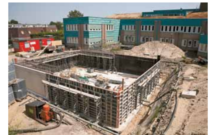
RHC Zuidoost Utrecht in aanbouw, 2010. Foto: W.R. Leeman
