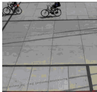
referentie Maaskade- stelconplaten als bekleding
