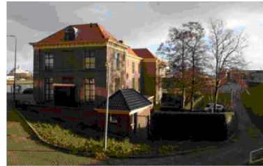
achterzijde gebouw het 'Loodswezen'
