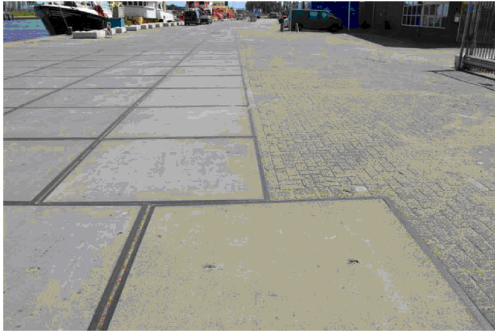
stelconplaten gemengd met straatstenen op de huidige kade in het zuidelijk deel
