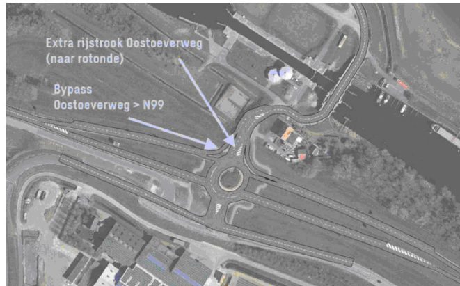
Figuur 4: De doorgevoerde maatregelen op de rotonde Oostoeverweg – N99
