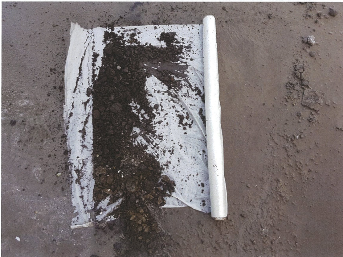
Boring bij DKM16, diepte ca. 1,0 m daarna beton
