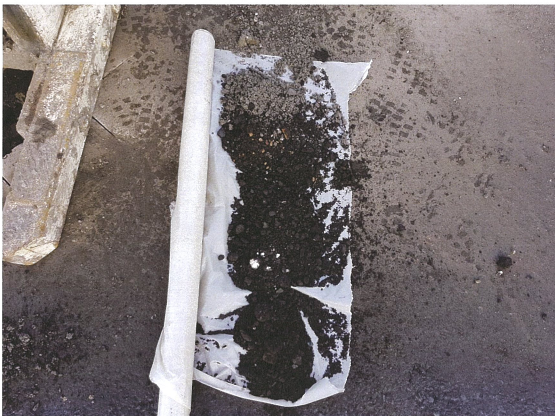
Boring bij DKM19, diepte ca. 1,0 m daarna beton
