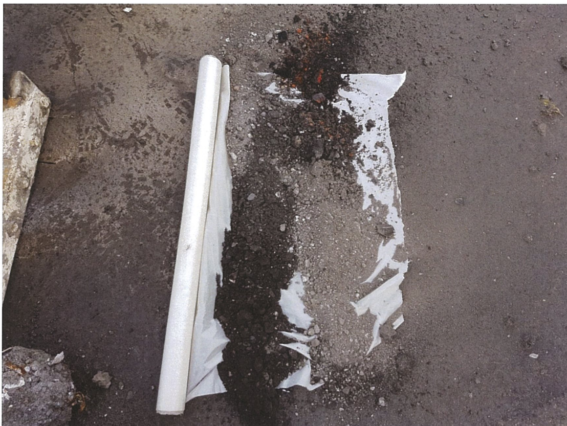
Boring bij DKM5, diepte ca. 1,8 m
