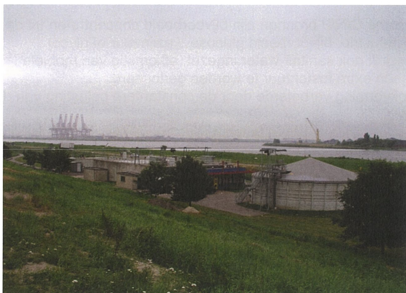
Percolatie zuivering Afvalzorg aan het Noordzee kanaal.
